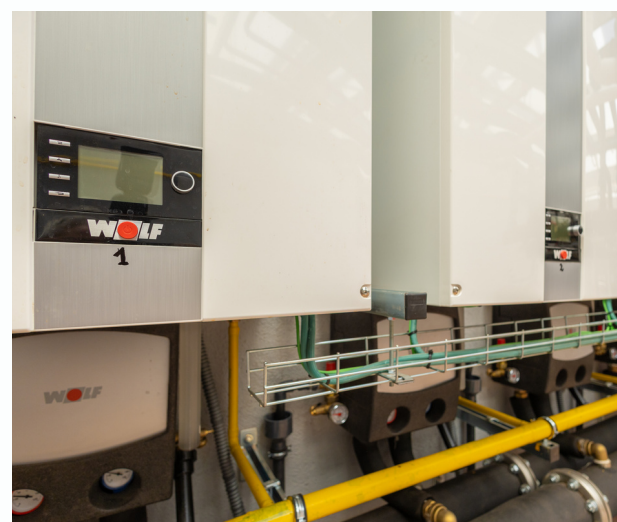
2. Canvi de calderes al Campus Diagonal Nord
